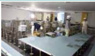
OAフロアの施工
