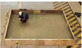
型枠の施工
